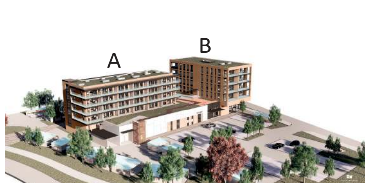
Byggetrinn 1 (fasade vest) innflytting Q4 2020.
